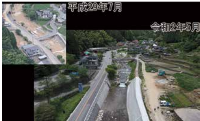
ドローンによる災害復旧撮影
